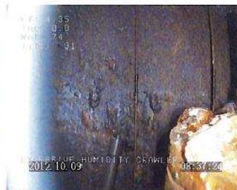
Bride de pompe et morceau de tube guide sonde
