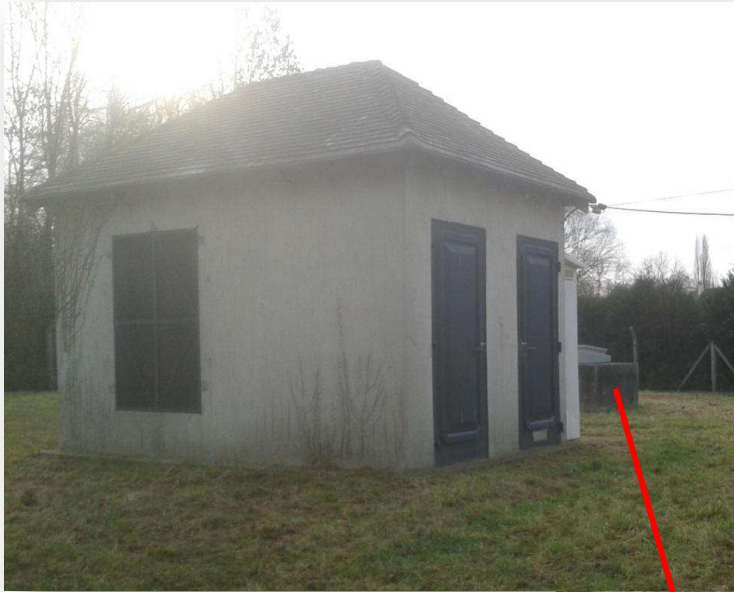
Forage de la Peupleraie- Vue sur la station de pompage et le forage (Crédit photo : Explor-e)
