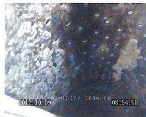
Rouille et concrétions sur une partie du tube
